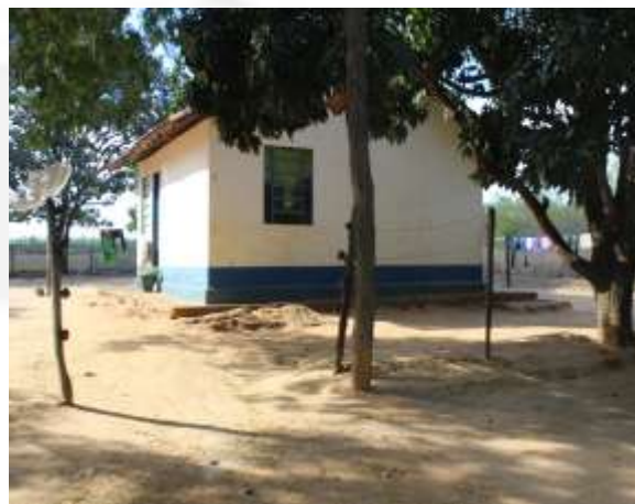
Foto 04. Residência na área do empreendimento
