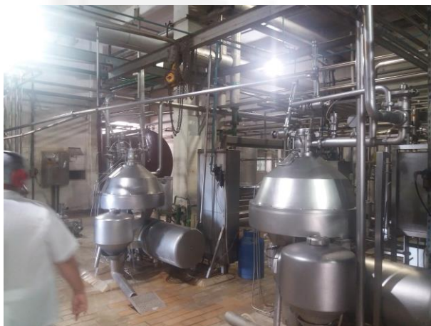
Foto 04. Vista geral na área operacional
