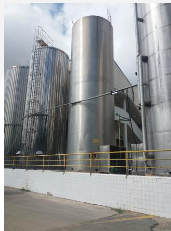
Foto 02. Silos de armazenamento.
