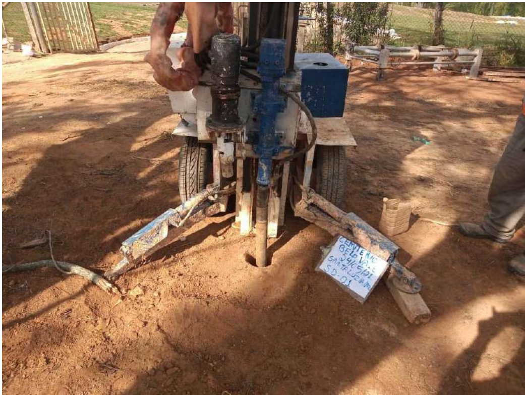
Foto 01 – Sondagem SD-01 em 24/05/2021
