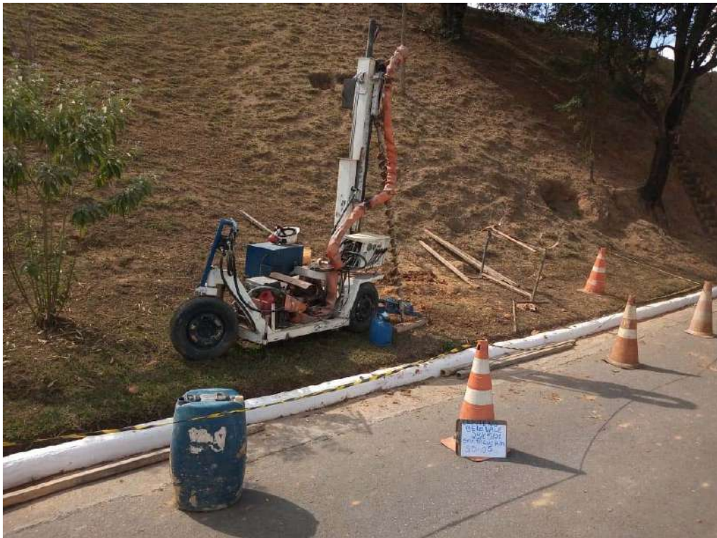
Foto 03 – Sondagem SD-05 em 28/05/21.
