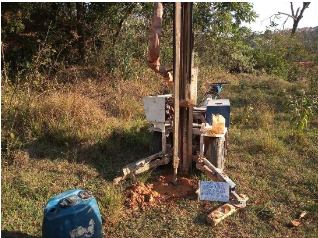
Foto 04 – Sondagem SD-06 em 28/05/21
