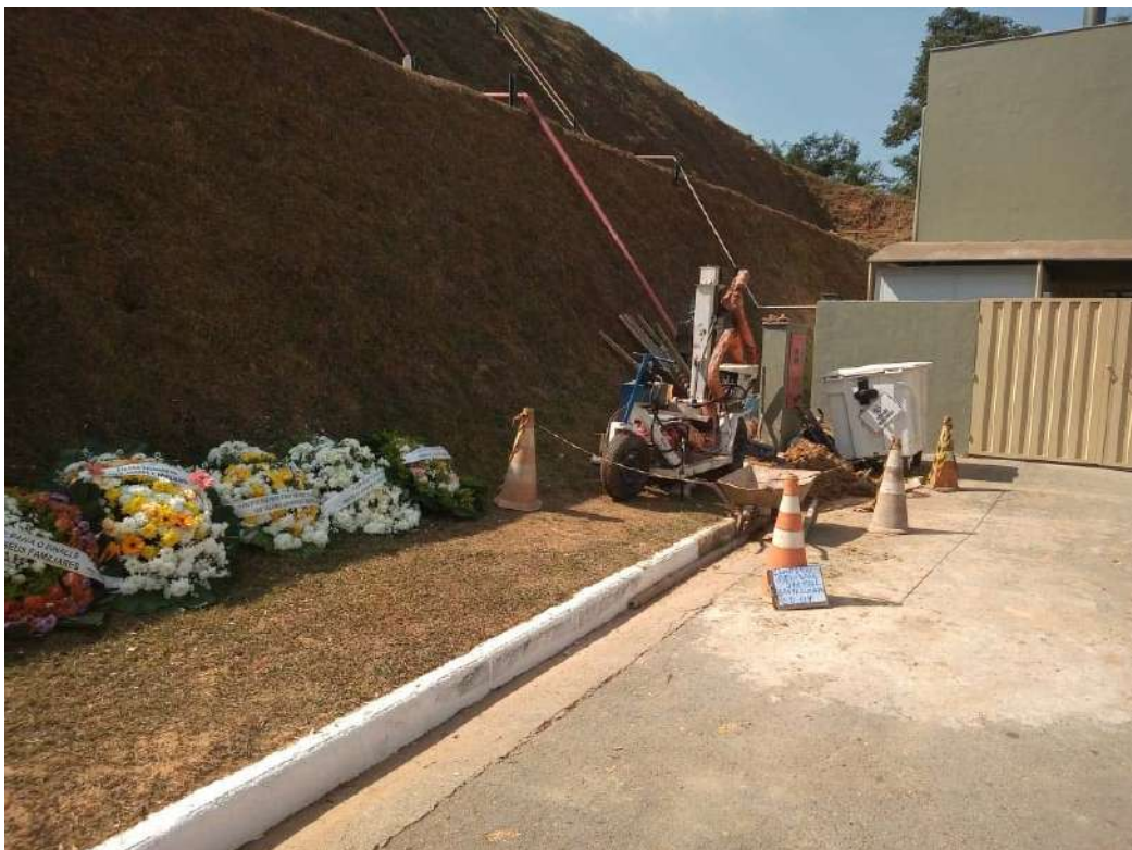
Foto 02 – Sondagem SD-04 em 27/05/2021
