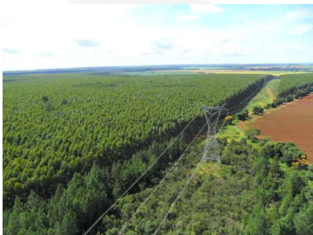
Linha de Transmissão LT. Área de vegetação nativa e área de silvicultura
