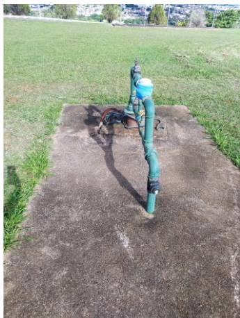
Foto 6: Poço tubular
