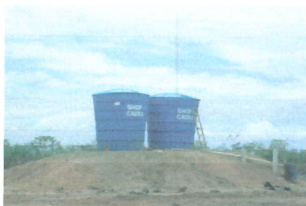
Foto: Caixas d'água.
