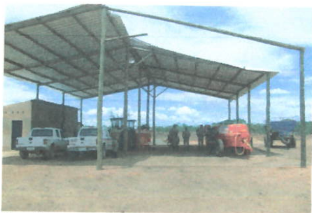
Foto: Casa de máquinas e máquinas.
