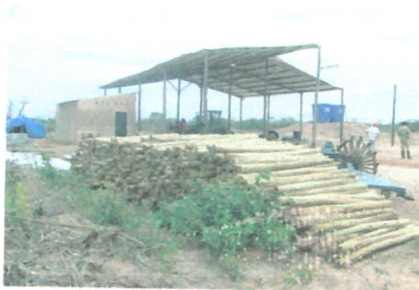
Foto: Benfeitoria construída na propriedade. Casa de máquinas, máquinas, mourões e água.
