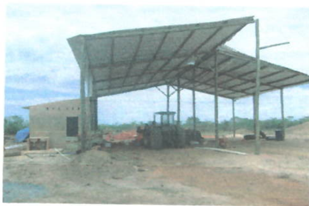
Foto: Casa de máquinas e máquinas.
