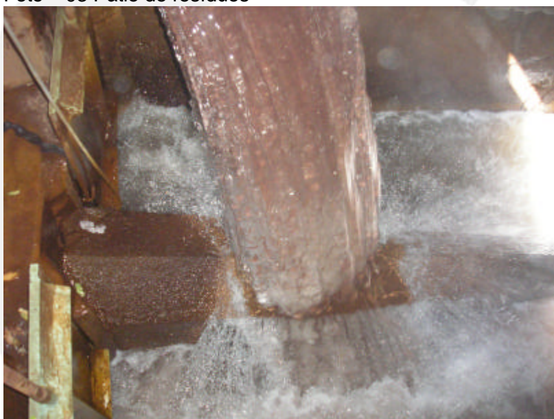
Foto – 04 Emissário PQH2 origem da ETE onde são tratados também os efluente líquidos da área de aciaria e laminação.
