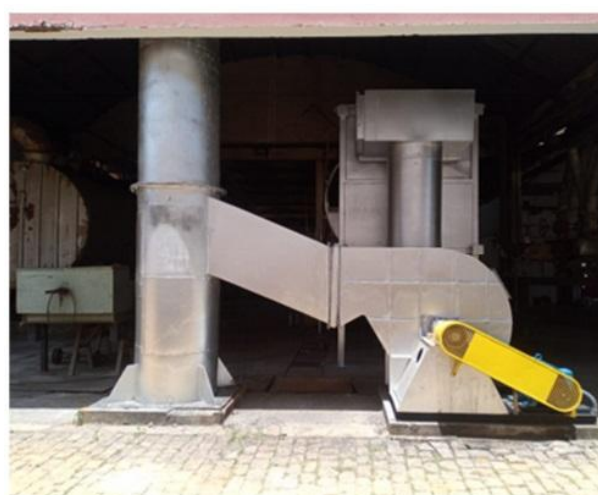
Figura 14: Caldeira IX, após a reforma, e seu sistema de controle de particulados. Fonte: informações complementares.
