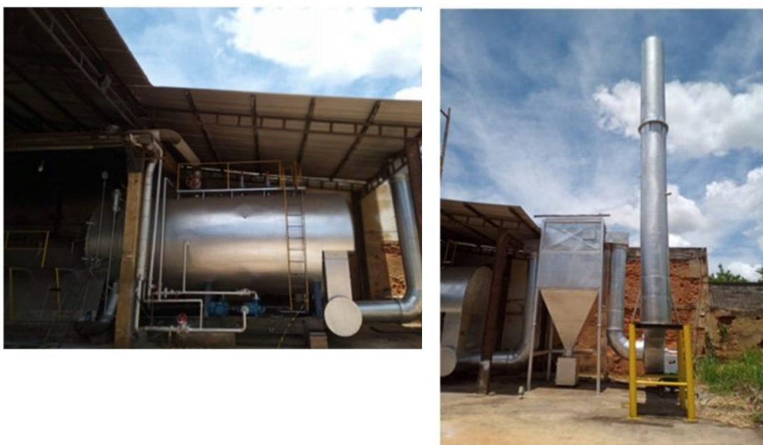
Figura 15: Caldeira X, após a reforma, e seu sistema de controle de particulados. Fonte: informações complementares.
