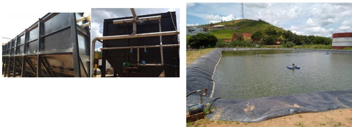
Figura 09: Tanque sedimentador (a esquerda) e lagoa aerada (a direita), com os aeradores instalados Fonte: informações complementares.
