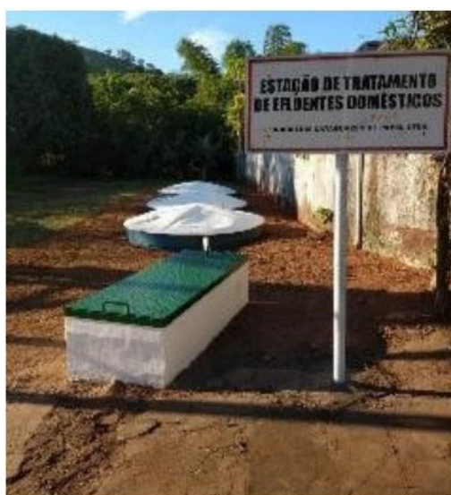
Figura 07: Sistema de tratamento de efluentes sanitários. Fonte: informações complementares.
