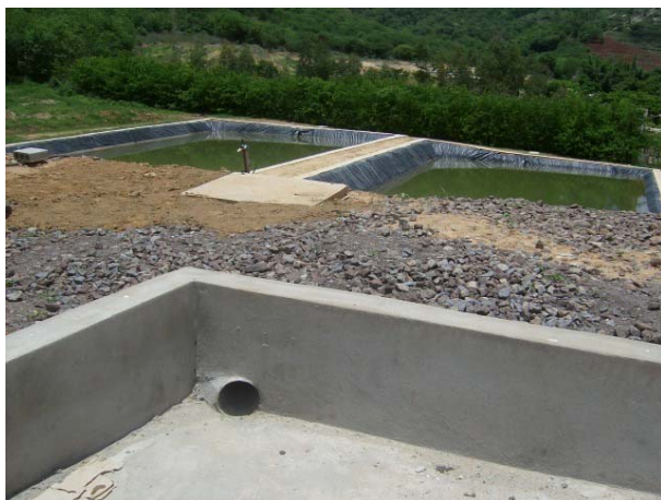
Foto 01. ETE do Matadouro (esquerda) e do Aterro (direita)
