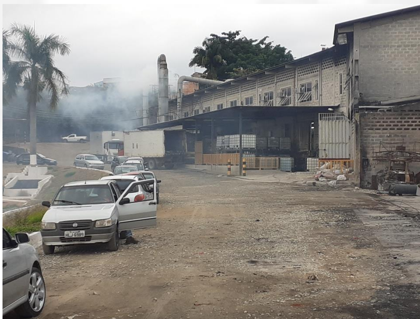
Figura 02: Emissão de névoa da chaminé única após modificação do sistema de mitigação dos efluentes atmosféricos observada de outro ponto do empreendimento. Fonte: Vistoria – 21/08/2020.
