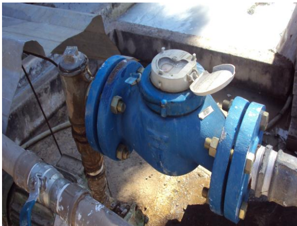
Figura 7 – Hidrômetro instalado
