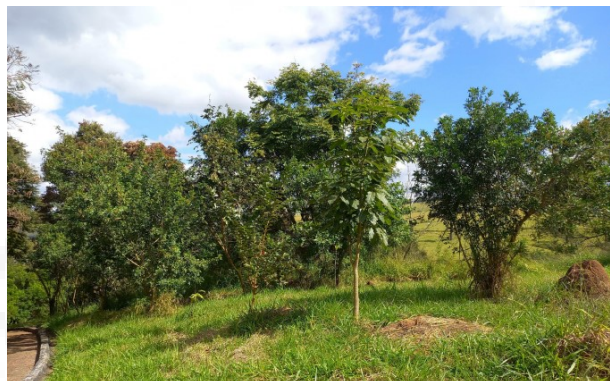
Figura 10: Vista geral da área da ETE (cobertura vegetal dos taludes e vegetação arbórea plantada pela COPASA)
