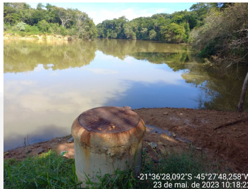
Figura 8: Detalhe do ponto de lançamento do efluente final da ETE São José no Rio Verde
