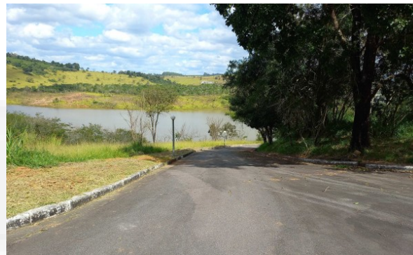
Figura 2: Vista geral da entrada de acesso elevatória, tratamento preliminar, leito de secagem
