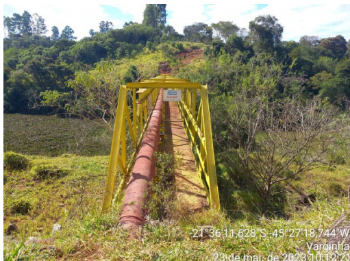
Figura 7: Detalhe do emissário final após construção da PCH Boa Vista
