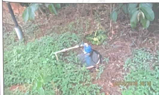
Foto 09: Poço manual em atividade na área de lazer.
