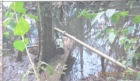
Foto 12: Conjunto motobomba utilizado na área de abate de peixes.
