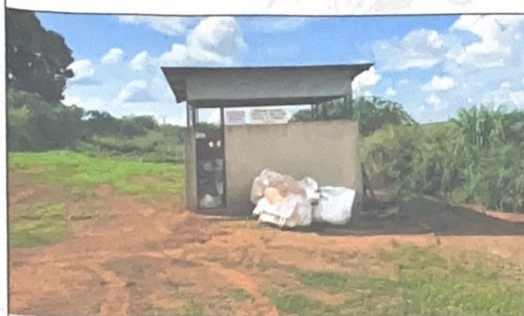
Foto 03: Abrigo de embalagens vazias sem sinais de queima de resíduos.
