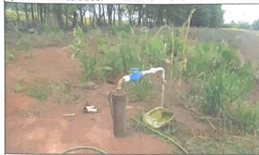
Foto 05: Poço tubular utilizado na dessedentação de animais da granja.
