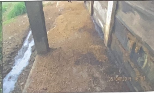
Foto 08: Vista parcial da composteira com falha no manejo e com escoamento de chorume sobre o solo.
