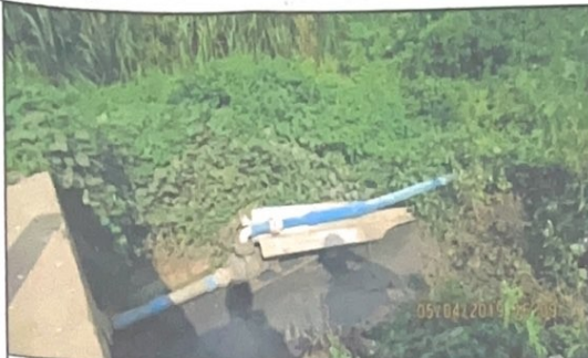
Foto 07: Vista de dejetos sem tratamento, vazando por o solo.
