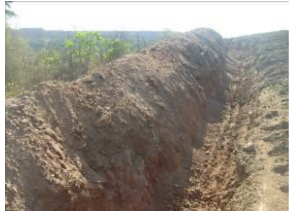
Trincheira para drenagem da lavra leste
