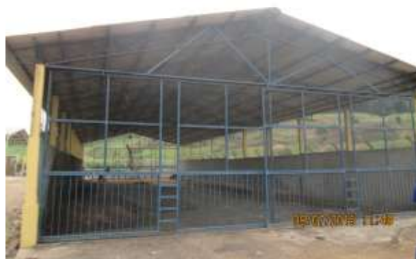
Foto 03. Galpão de compostagem
