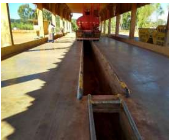
Foto 03. Pista de lavagem de veículos e máquinas.
