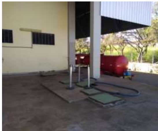
Foto 02. Caixa de acumulação de efluente industrial da Classificação Central de Ovos.
