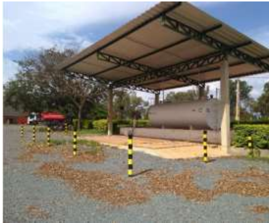
Foto 06. Área de armazenamento de combustíveis.
