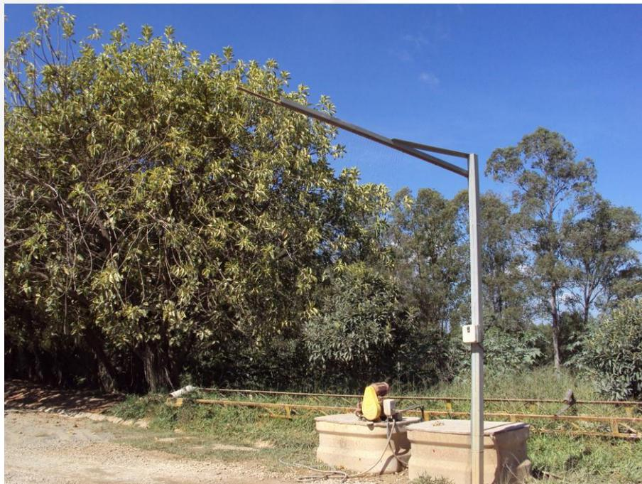
Foto 1. Sistema para umidificação do calcário antes da descarga.
