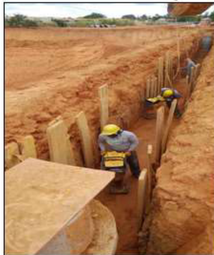
Execução da rede de drenagem
