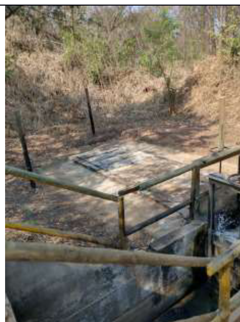
Foto 04: Dissipador de Energia
