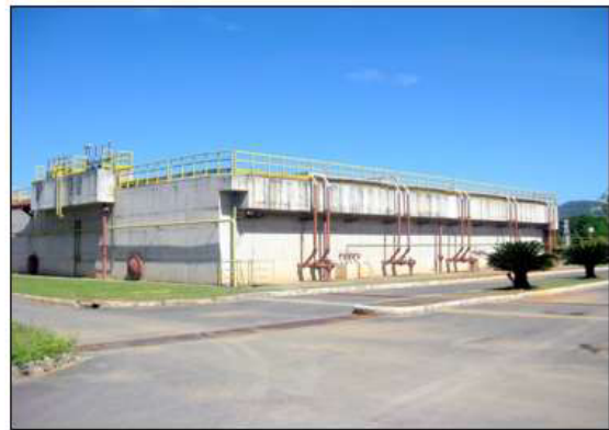
Vista do detalhe das tubulações de descarte do lodo e o sistema de amostragens do lodo.
