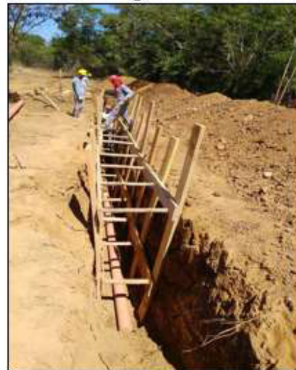
Execução da rede de drenagem
