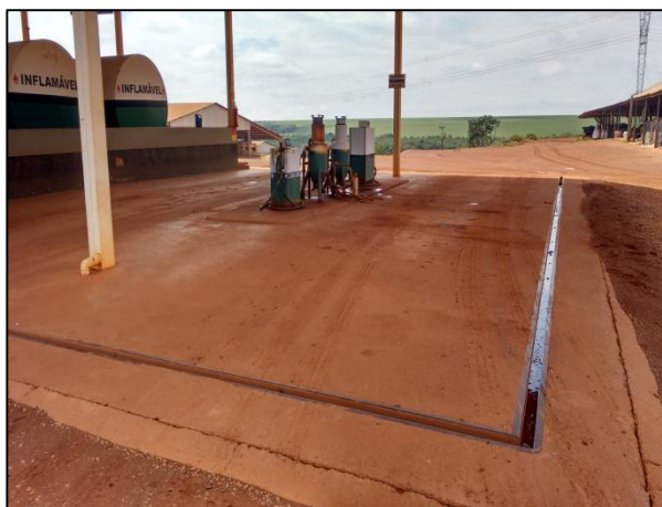
Foto 02. Posto de abastecimento
