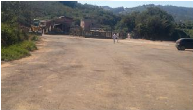
Foto 11. Vias internas pavimentadas
