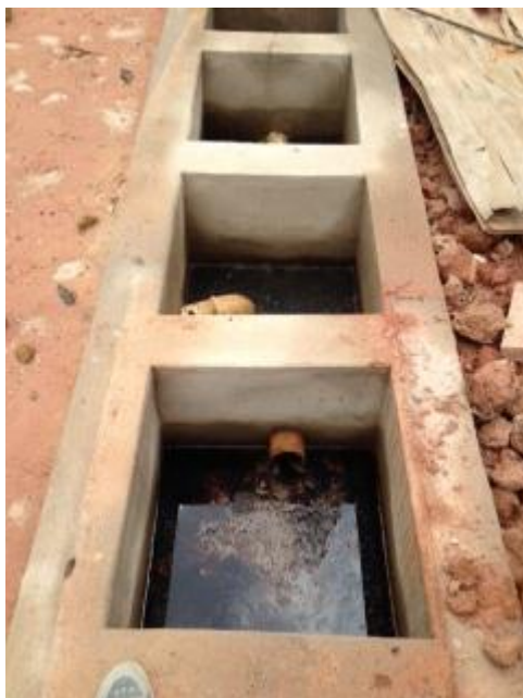
Foto 5. Implantação da caixa SÃO na área de lavagem dos caminhões
