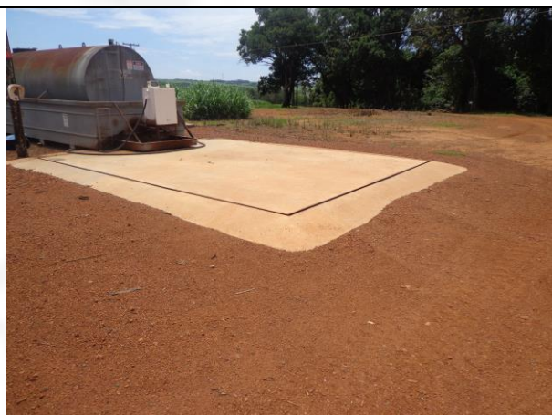
Figura 08. Área de abastecimento de combustível - área impermeabilizada com canaletas
