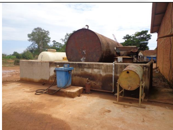
Figura 07. Área de abastecimento de combustível – bacia de contenção
