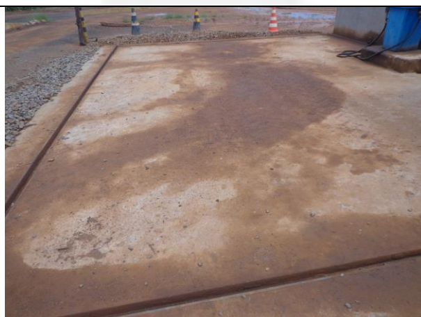
Figura 09. Área de abastecimento de combustível - canaletas
