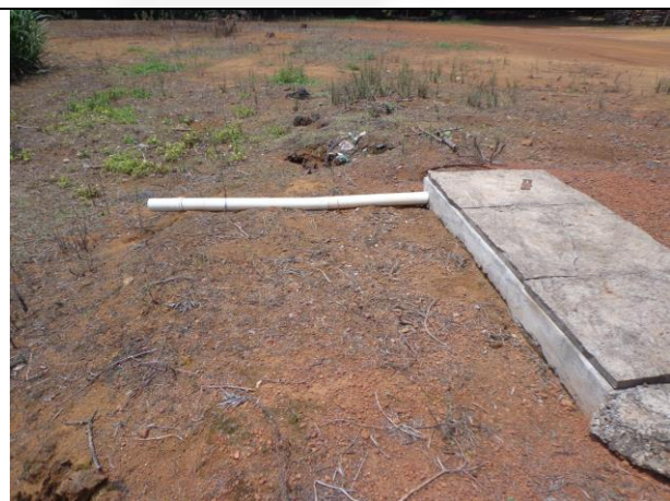
Figura 01. Caixa separadora de água e óleo
