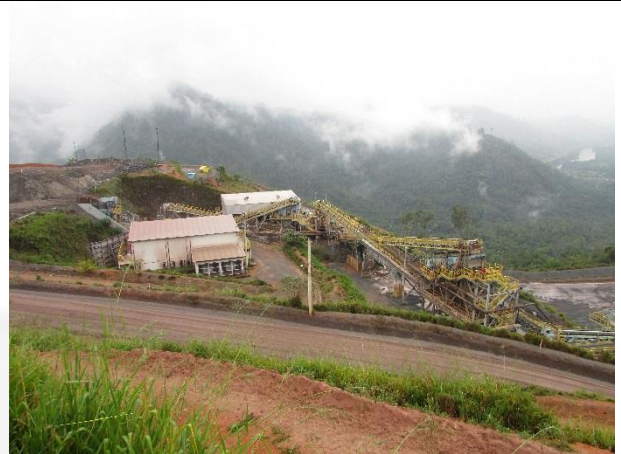
Fotografia 08: Vista superior da área da UTM.
