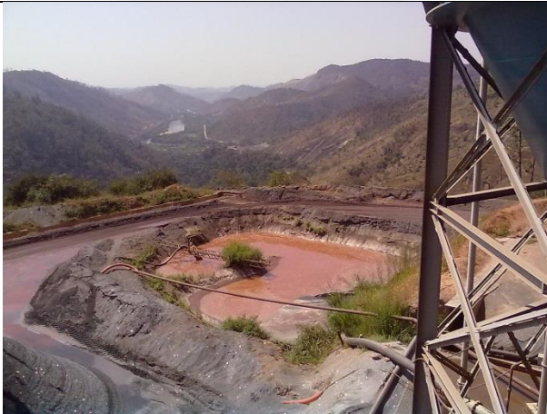
Fotografia 03: Baía existente na área da UTM.
