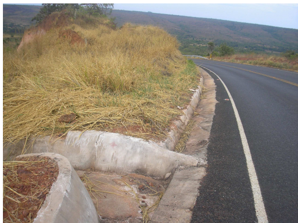
Foto 03. Controles das águas pluviais
