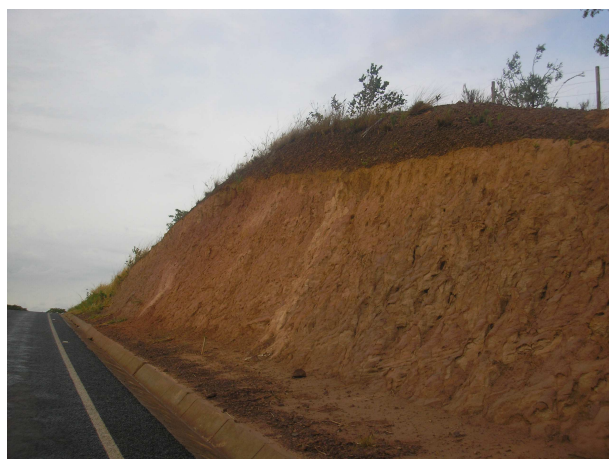
Foto 02. Corte de estrada
