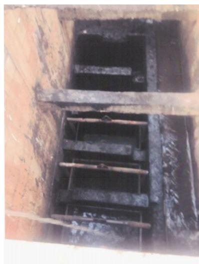
Foto 8 - Caixa retenção sólidos (limpeza)
