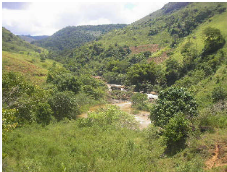
Foto 1. Local de intervenção da PCH.
