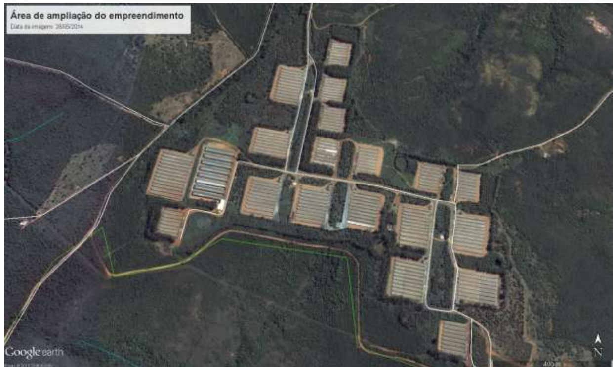
Figura 2 – Imagem do empreendimento na data de 28/05/2014 – Ainda sem ampliação.
