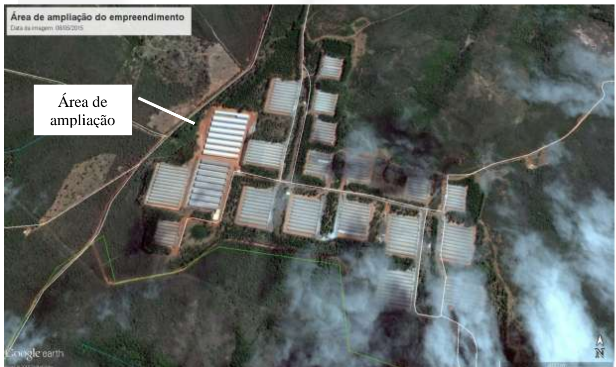
Figura 3 – Imagem do empreendimento na data de 08/05/2015. Nota-se que a construção já está finalizada.
