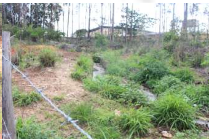
Foto 54: Efluente sanitário e industrial disposto a céu aberto.
