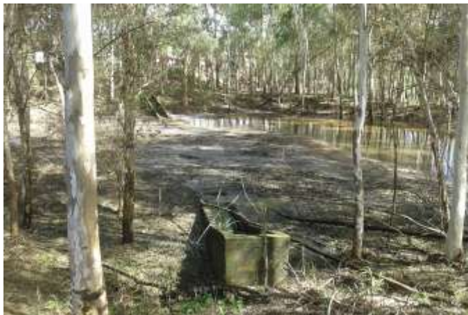
Foto 61: Bacia de contenção pluvial que também recebe efluente da área dos galpões.
