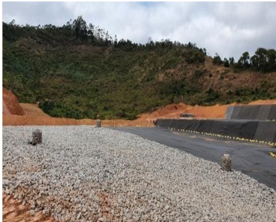
Imagem 1 – Vista da impermeabilização do aterro
