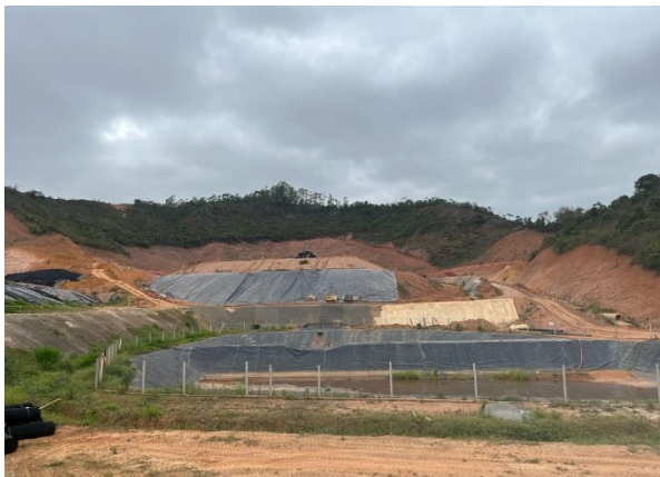
Imagem 3 – Área do aterro devidamente protegida.
