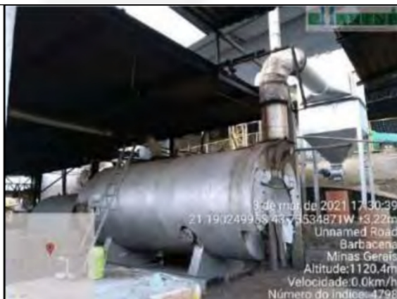
Imagem 01: Caldeira instalada na área do abate de aves e sistema de controle de emissões atmosféricas instalado (multiciclone)
