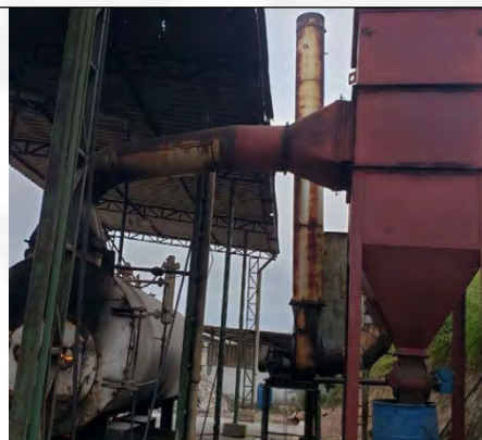
Imagem 02: Caldeira instalada na área do abate de bovinos e suínos e sistema de controle de emissões atmosféricas instalado (multiciclone)
