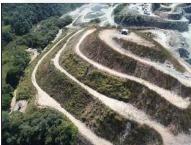
Foto 03 – Vista parcial da pilha de rejeito/estéril com destaque para os taludes que estão em processo de revegetação/recuperação (BELMONT - Agosto/2020)
