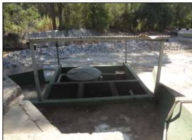
Foto 08 – Caixa desarenadora/Caixa SAO do empreendimento (VISTORIA SUPRAM/LM - 04/09/2019).
