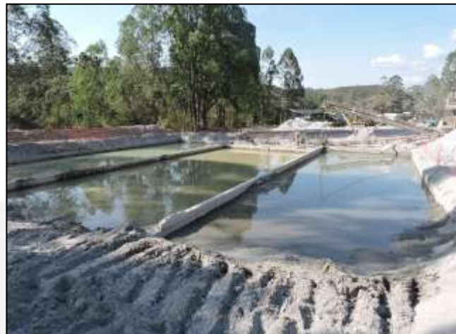
Foto 06 – Bacias de decantação construídas em concreto armado para onde é destinado o efluente industrial (BELMONT - 2019). Após a secagem, o material sólido é destinado a comercialização (super-fino), utilizado para reboco de parede e argamassa.
