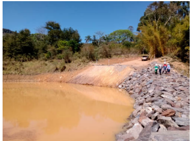
Imagem 2: Intervenções emergenciais para a contenção de sedimentos.
