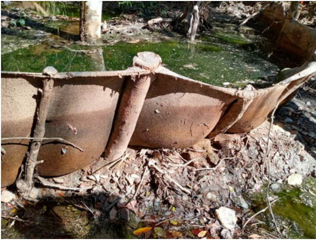
Imagem 5: Antigas estruturas de contenção de sedimentos.
