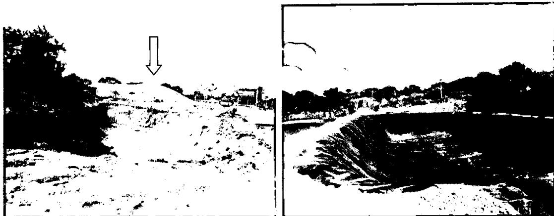
Na primeira foto vemos a nova lagoa em fase final de escavação com o biodigestor na cor branca ao fundo e na segunda foto vemos a nova lagoa devidamente impermeabilizada.
