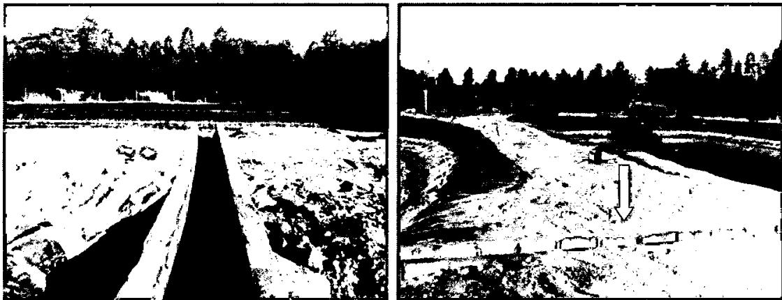
**Item 7 –** Foram implantadas fossas sépticas em todos os pontos onde há geração de efluentes domésticos, inclusive os efluentes dos funcionários da granja, os quais haviam sido direcionados para o biodigestor, mas como os efluentes serão utilizados na fertirrigação de pastagens, tornou-se necessário o seu tratamento à parte para evitar possíveis contaminações para os bovinos.
