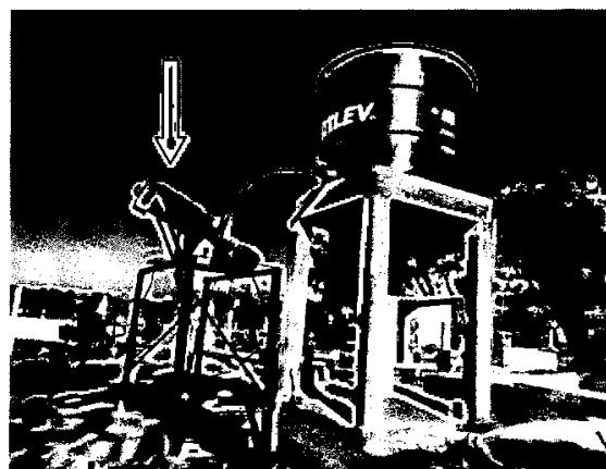
**Item 2** – Reforma do biodigestor. Além da limpeza foi implantada uma nova cobertura, conforme vemos nas fotos abaixo. Antes a cobertura era na cor branca.
