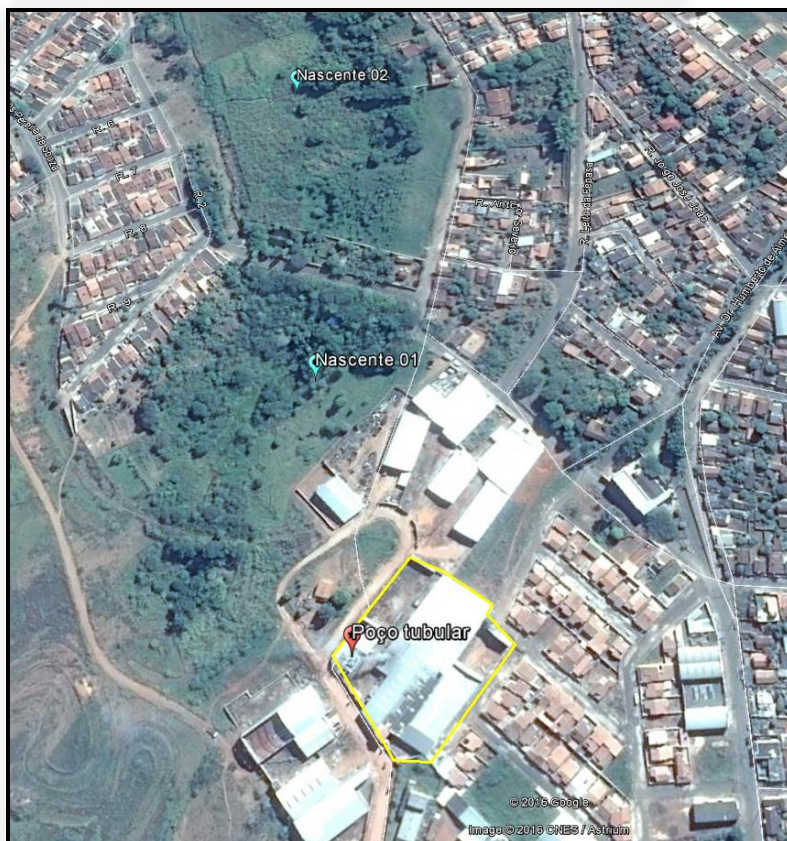
Imagem 02 – Locais de captação do poço tubular e das 02 nascentes
