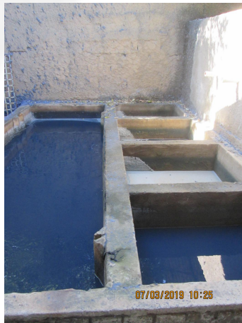
Figura 03: estruturas da ETE industrial – captação do efluente.
