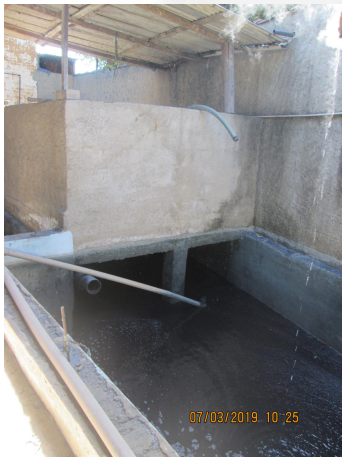
Figura 03: estruturas da ETE industrial – captação do efluente.
