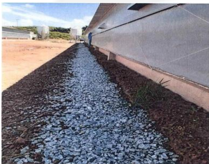
Foto 06: drenagem de água pluvial.
