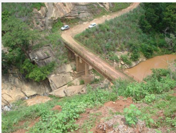
Foto 03. Ponte instalada sobre o TVR.
