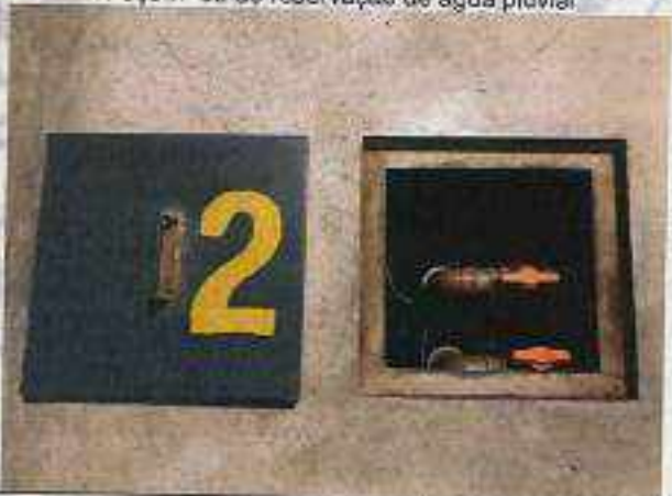
Poço nº 02 de reservação de água pluvial
