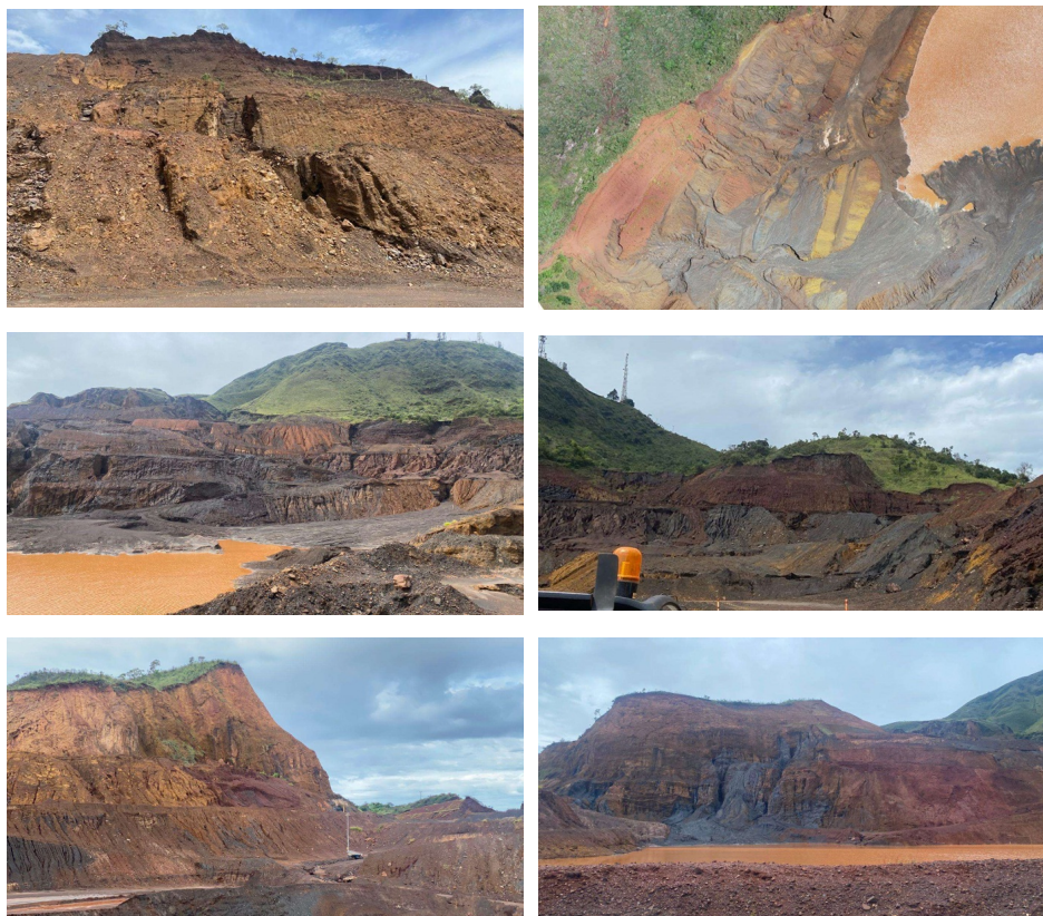
Figura 6 - Processos erosivos nos taludes da cava (Sump 4) Mina Corumi. Fonte: EMPABRA, 2024.
