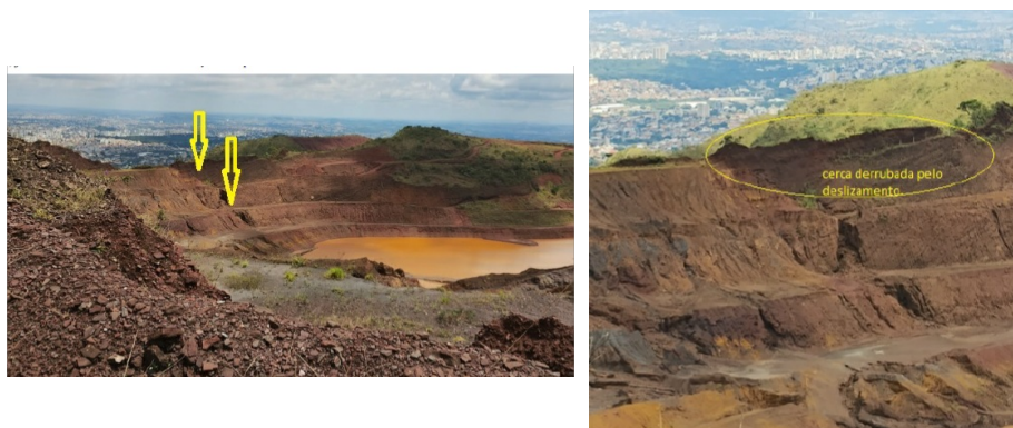
Figura 16 - Detalhes dos deslizamentos ocorridos nas bancadas da cava e, do processo erosivo que está se desenvolvendo no barramento com a derrubada da cerca do Parque Estadual da Baleia.
