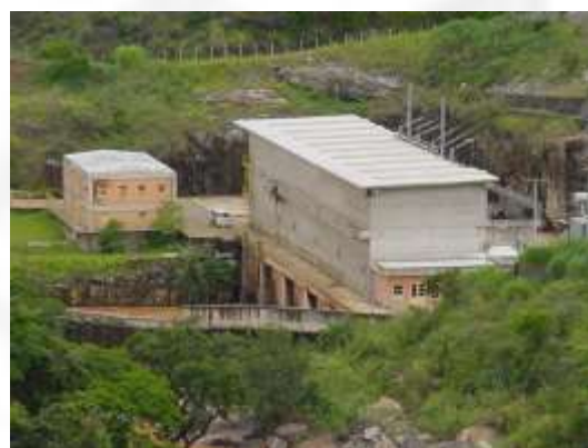
Foto 04: Casa de força
