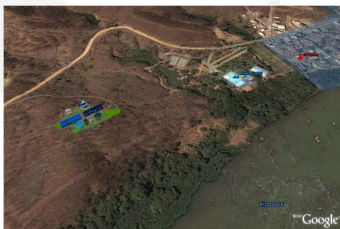
Foto 05: Local de instalação da ETE Elvamar.
