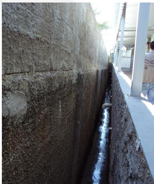
Foto 9: Sistema de drenagem de águas pluviais.
