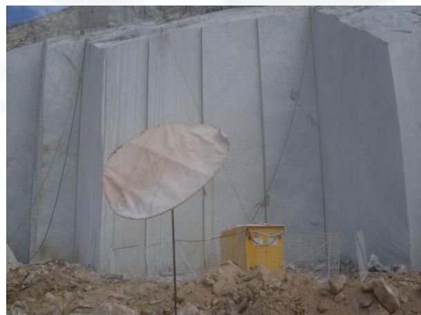
Foto 04. Máquina de fio diamantado operando.
