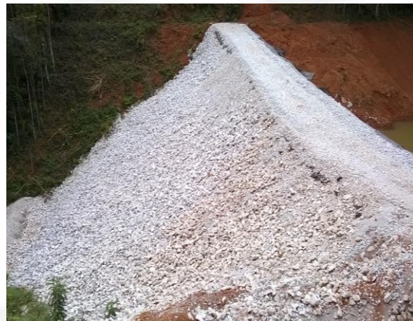
Foto 04. Dique da pilha de estéril de Crista
