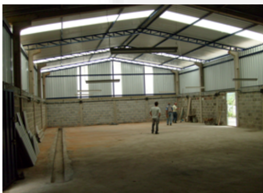
- Vista interna do galpão.
