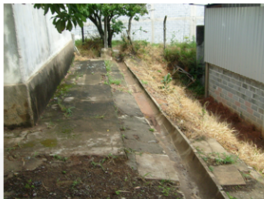
Canaletas de drenagem.
