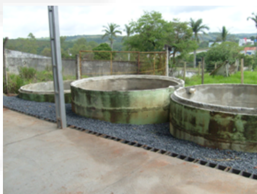
- Tubulões leito de secagem
