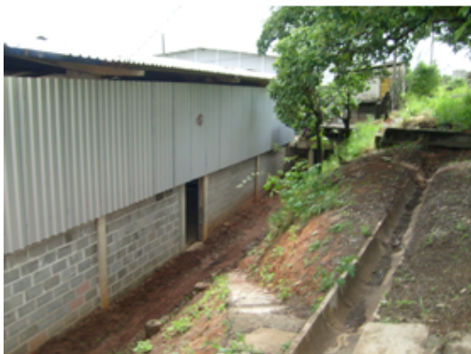
Canaletas de drenagem
