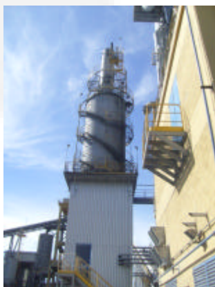
Foto 03. Silo para armazenamento de insumo
