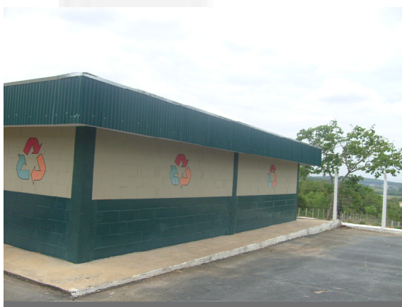
Foto 11. Depósito de resíduos
