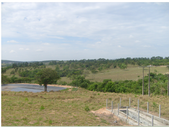
Foto 05. Tratamento preliminar e estação de tratamento industrial. Ao fundo, reserva legal.
