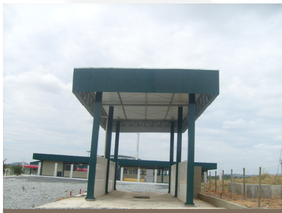
Foto 03. Área de lavagem de veículos
