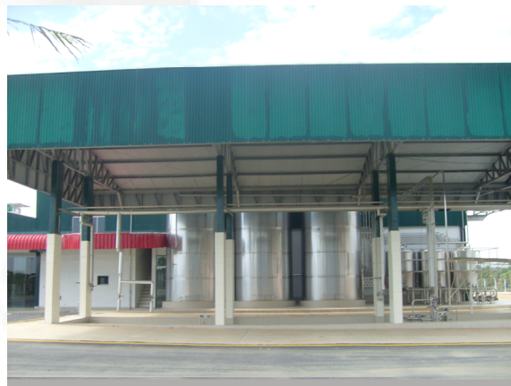
Foto 02. Área de descarga
