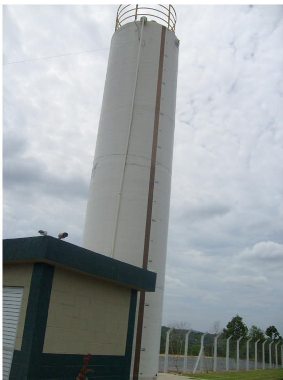
Foto 09. Armazenamento de água
