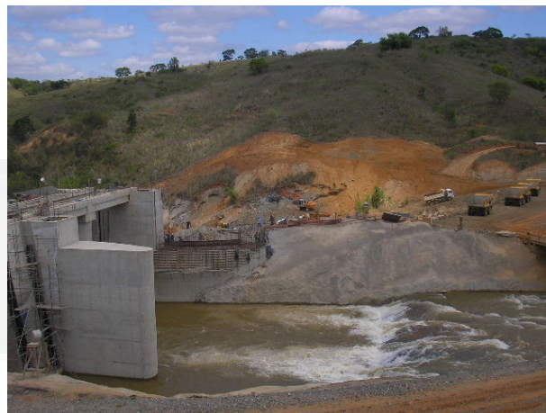
Foto 02. Localização do barramento com sua tomada d'água à esquerda.
