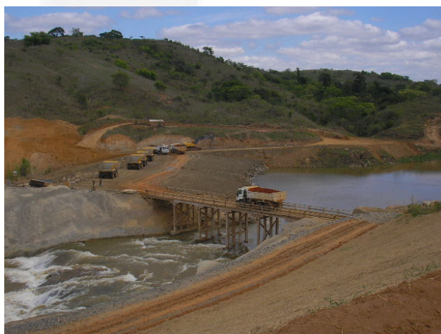
Foto 03. Ponte no detalhe foi removida para enchimento.
