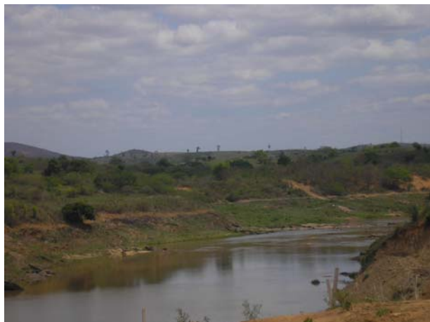
Foto 01. Área limpa apta para enchimento do reservatório.
