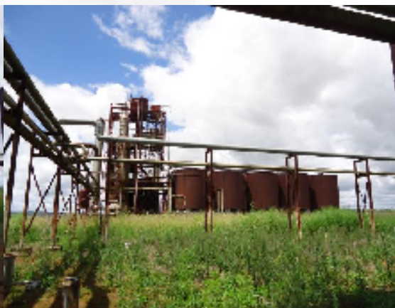
Foto 02. Instalações da antiga destilaria
