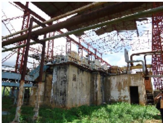
Foto 03. Instalações da antiga destilaria
