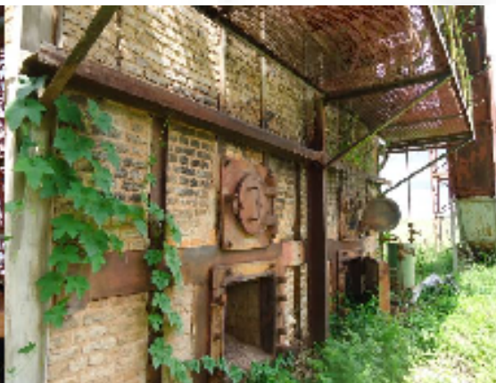
Foto 04. Instalações da antiga destilaria
