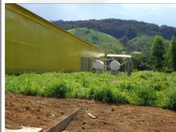
Base de armazenamento de metano
