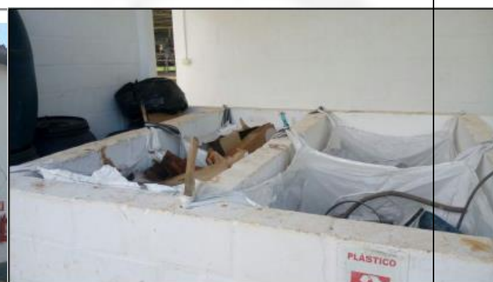
Depósito temporário de resíduos (vista superior)
