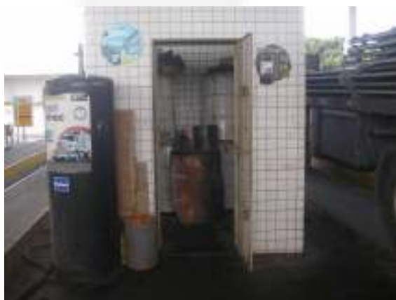
Foto 03. Depósito de armazenamento temporário de resíduos perigosos.
