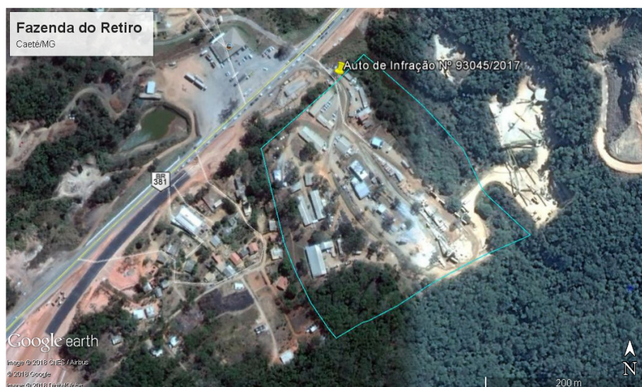
Figura 01 – Imagem referente ao canteiro de obras –Fonte PECF 2018
